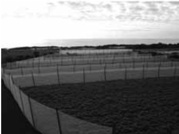
写真1 防風ネットの設置状況
